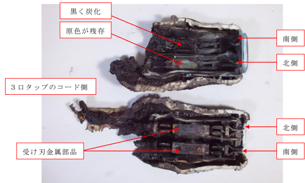
写真 11 3 ロタップ内部の状況
