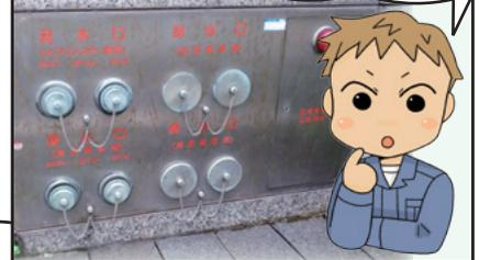
他には、「スプリンクラー設備」が設置されている場合、送水口が設けられていることが多い。これは、万が一スプリンクラー設備の水源のみで消火できなかった場合、消防車から送水することで安全に消火できるようにするために設置されている。
