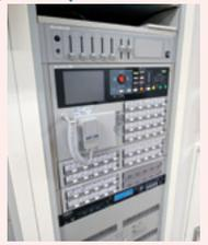
放送設備に信号が送られ自動的に放送設備が起動します
