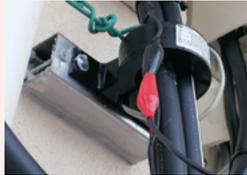
漏電火災警報器 (変流器)
