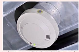
ガス漏れ火災警報設備 (検知器)
