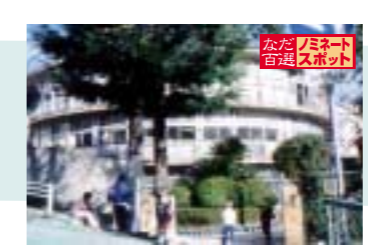
3 美野丘小学校の校舎は円形校舎。建設当時は神戸でも珍しかったようです。
