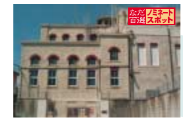
5 大正後期に建てられた関西電力瀬変電所。窓の上の赤いアーチがお洒落です。
