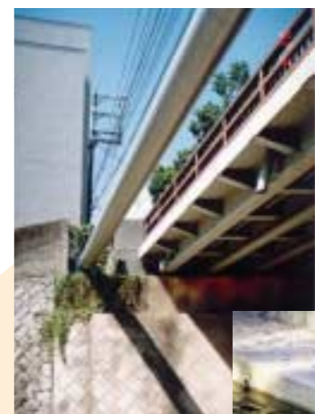
11 水道筋につながる篠原橋の横に水道管があります。大正時代に千苅水源池の水を上カ原浄水場へと引き、神戸市内に給水することになりました。この時水道管が通り下を通っていたので水道筋と呼ばれたそうです。
