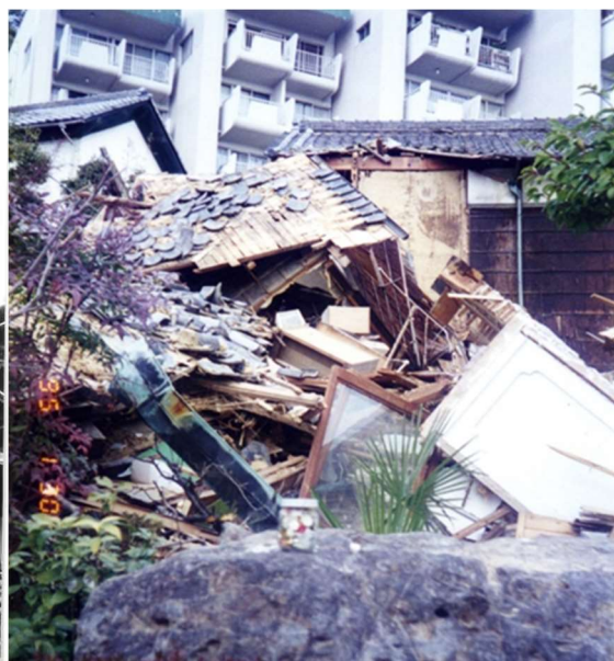
阪神大震災で全壊した鎖瀾閣
