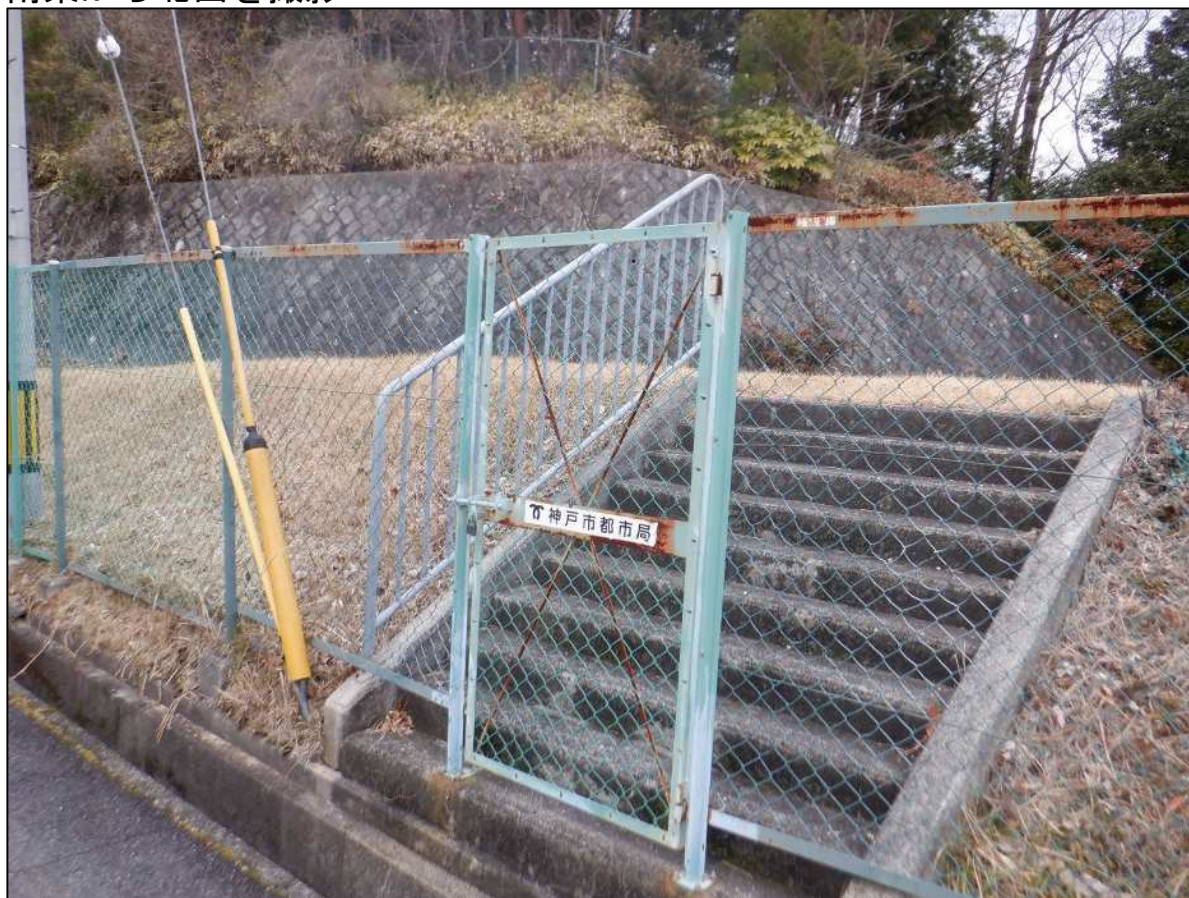
③南東から北西を撮影
