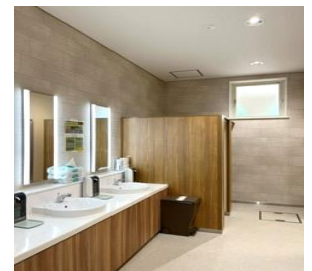
写真：トイレ照明器具 LED 化
