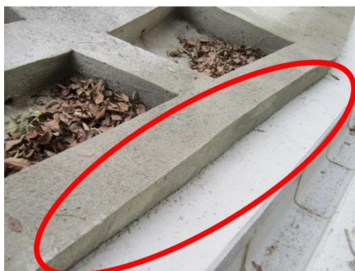
水抜きパイプの出口
