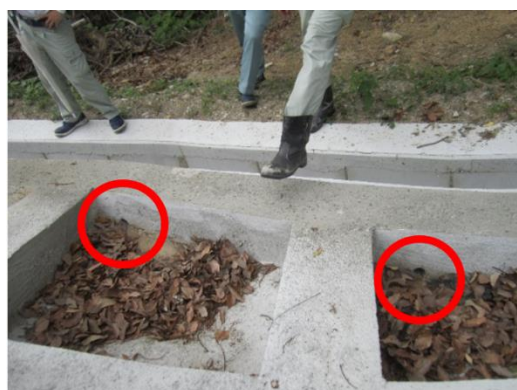
水抜きパイプの入口
