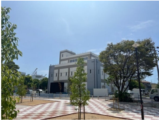
神戸駅周辺地区浸水対策事業（東川崎ポンプ場） （中央区 東川崎町）
