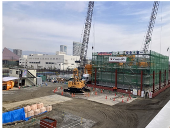
ポートアイランド処理場改築更新事業 (中央区 港島中町)
