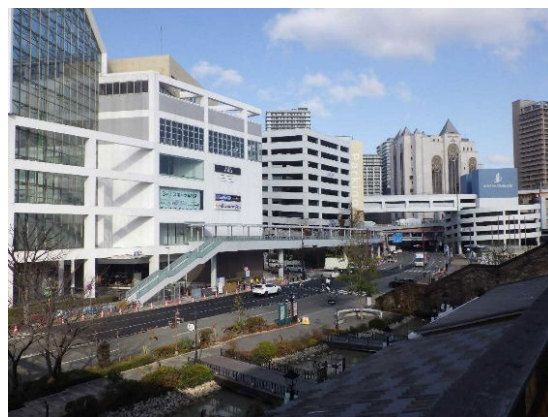
ハーバーランド東（弁天）デッキ 完成写真 （中央区 東川崎町）
