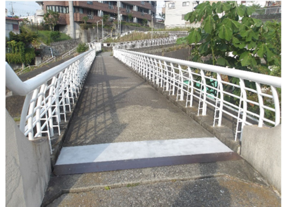
手すりの整備後 (須磨区 白川台 (千原歩道橋))
