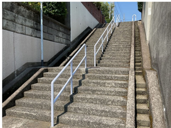
手すりの新設 (垂水区 つつじが丘)
