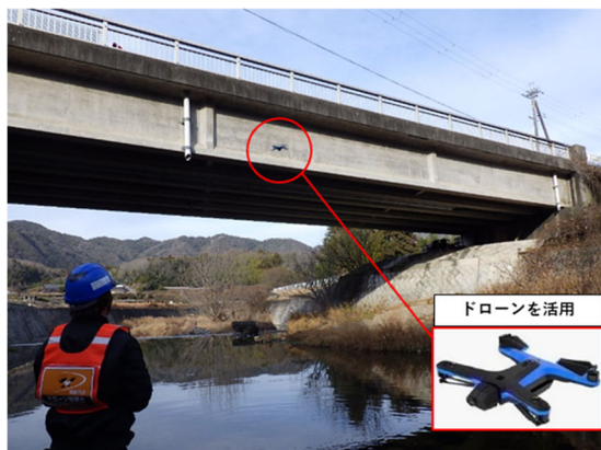
橋梁点検 (北区 大神橋)
