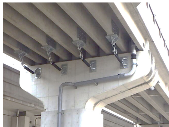
橋梁の耐震化 (西区 前開小寺第一高架橋)
