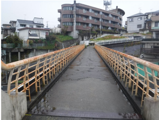
手すりの整備前 (須磨区 白川台 (千原歩道橋))
