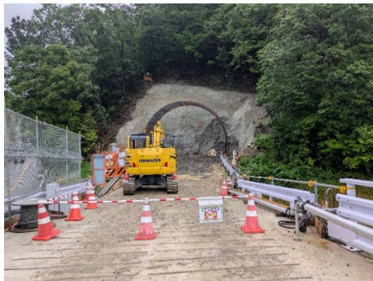
国道428号(箕谷北)整備状況
