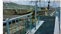
山陽電鉄山田川西踏切。令和7年9月18日工事完了。供用開始されました。
