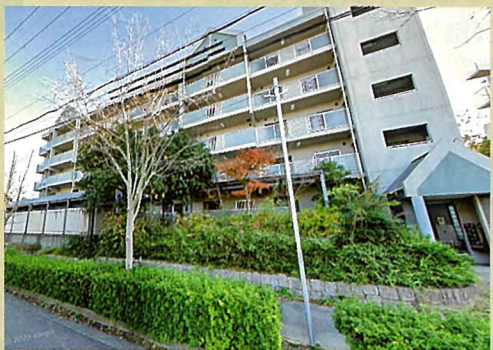
北区の市営住宅
