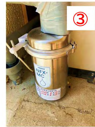
神出小学校に設置された浄水器 ①手洗い場 ②冷水機 ③給水機
