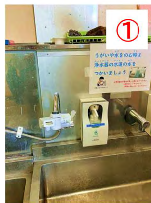
神出小学校に設置された浄水器 ①手洗い場 ②冷水機 ③給水機
