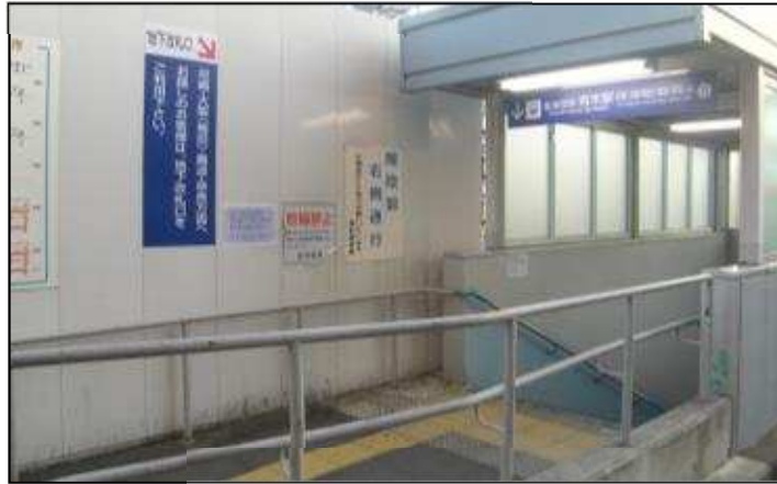
駅舎出入口(整備前)
