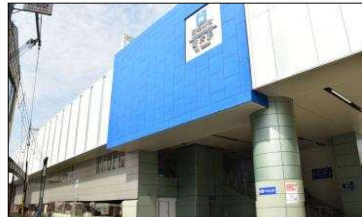
駅舎外観(整備後)
