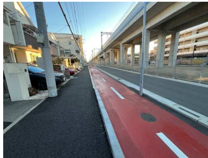
高架後の北側側道
