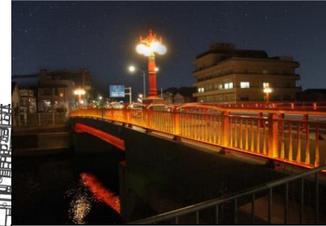
新川橋ライトアップ整備 (2026年8月完成予定)
