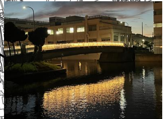
材木橋ライトアップ整備 (2024年完成)
