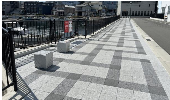
大輪田泊の石棕周辺整備（2024年完成）
