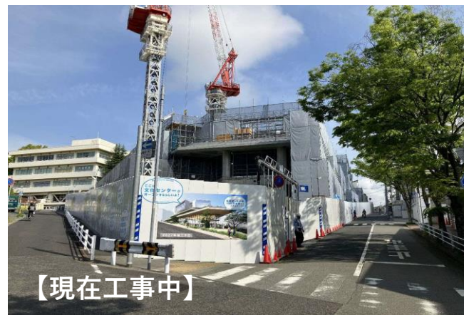
新北区文化センター、エスカレーターの整備
