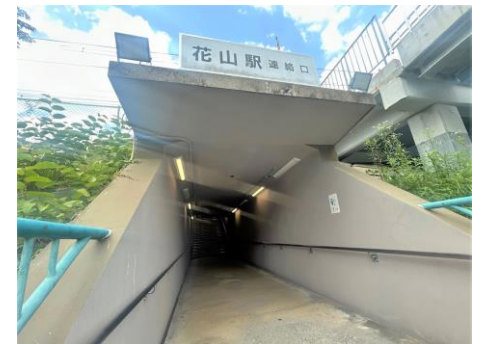
地下通路の美装化
