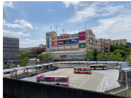
ロータリーの改修
