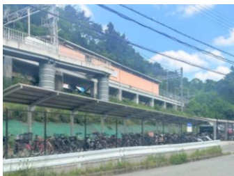
花山駅前自転車駐車場の整備
