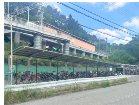
自転車駐車場整備
