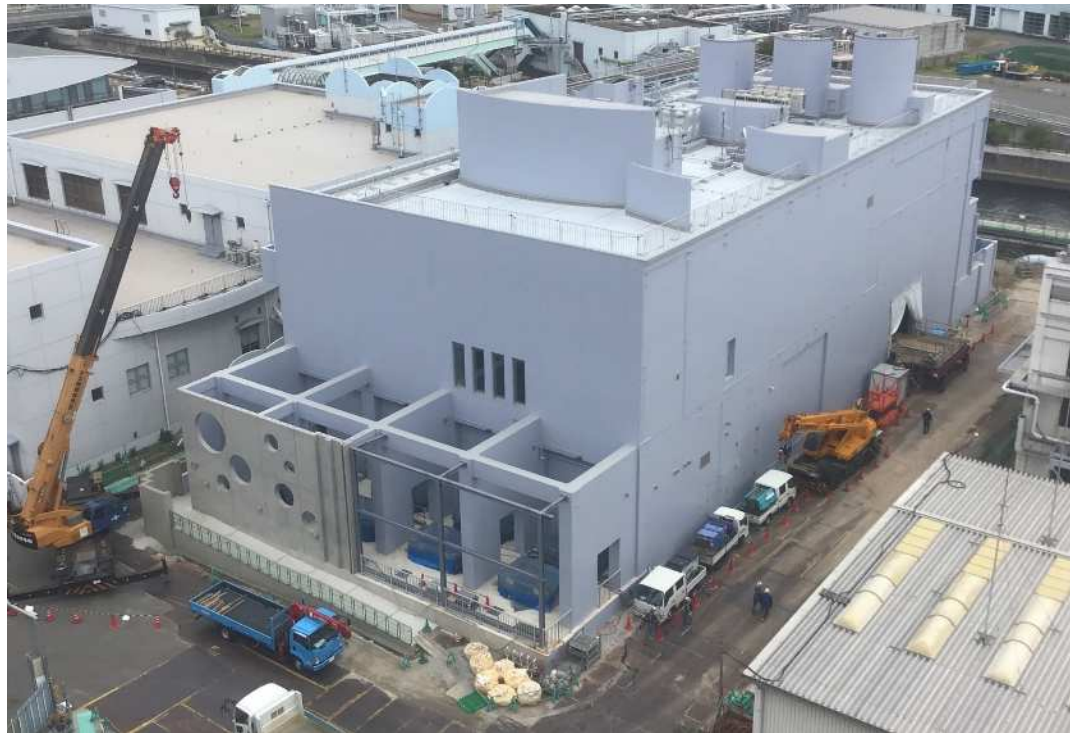
魚崎ポンプ場改築更新事業(第1期)
