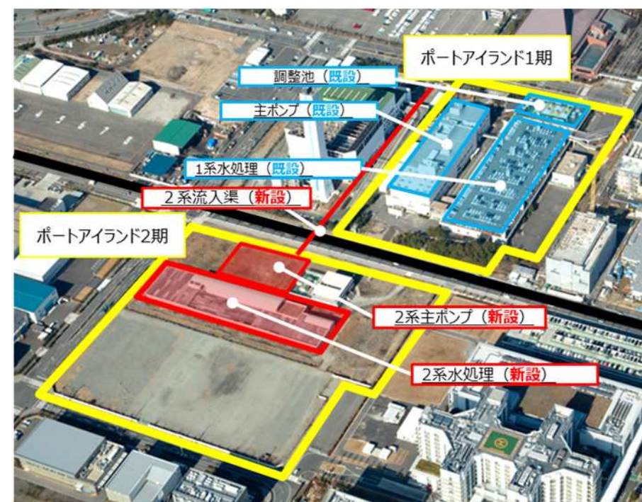
ポートアイランド処理場の改築
