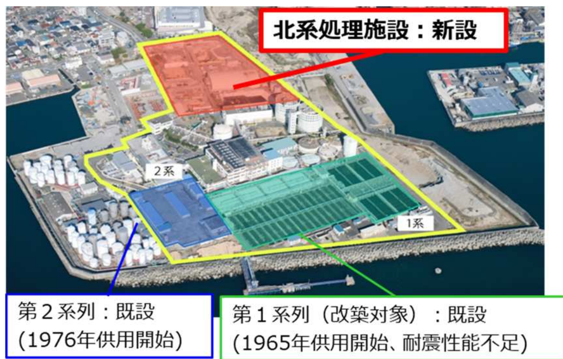
西部処理場の改築（北系水処理施設の築造）
