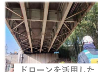
ドローンを活用した 橋梁点検
