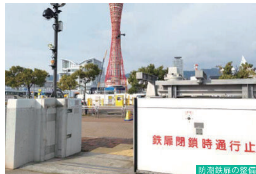
防潮鉄扉の整備
