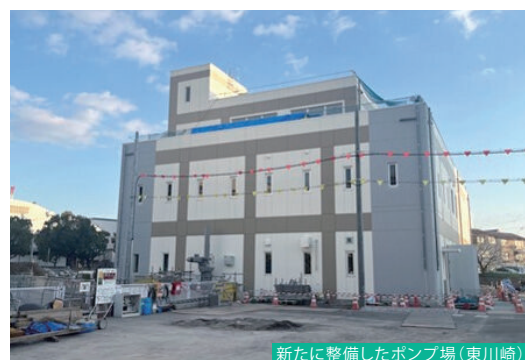
新たに整備したポンプ場(東川崎)
