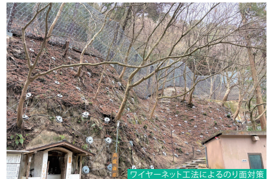
ワイヤーネット工法によるのり面対策
