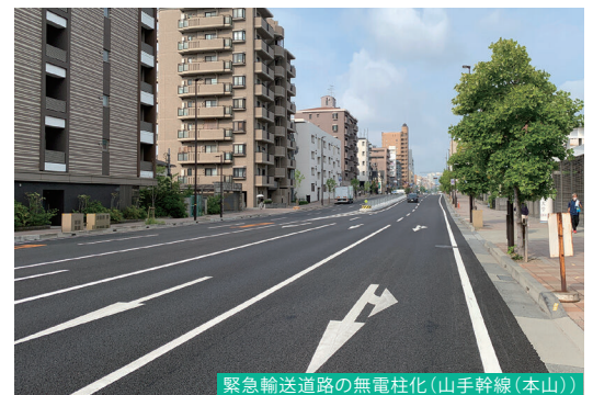
緊急輸送道路の無電柱化(山手幹線(本山))
