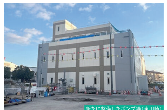
新たに整備したポンプ場(東川崎)
