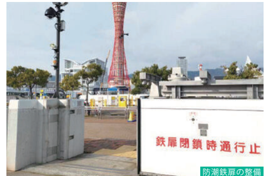
防潮鉄扉の整備
