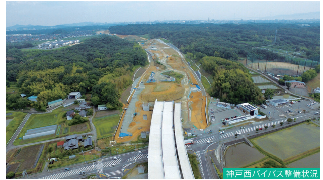
神戸西バイパス整備状況
