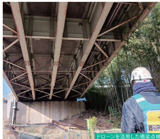
ドローンを活用した橋梁点検
