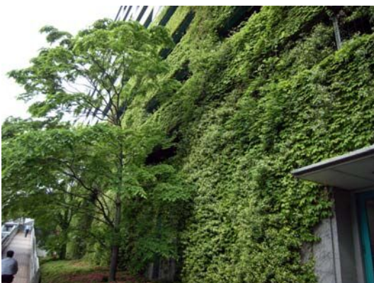
建築物の壁面緑化
