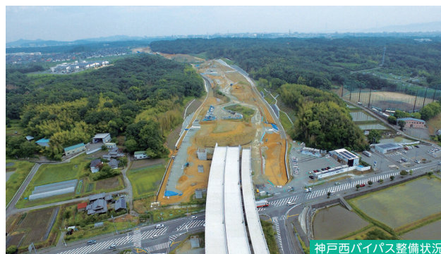
神戸西バイパス整備状況
