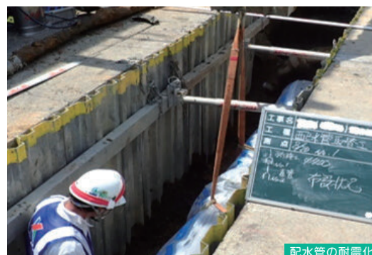
配水管の耐震化
