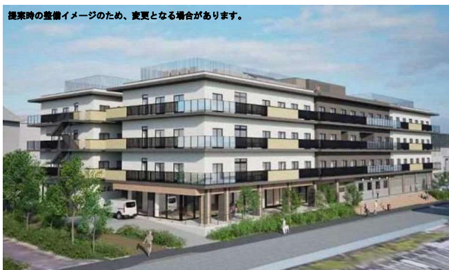
かりばプラザリニューアル（高齢者住宅）
