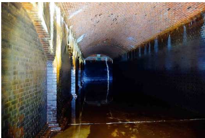
奥平野低層配水池
