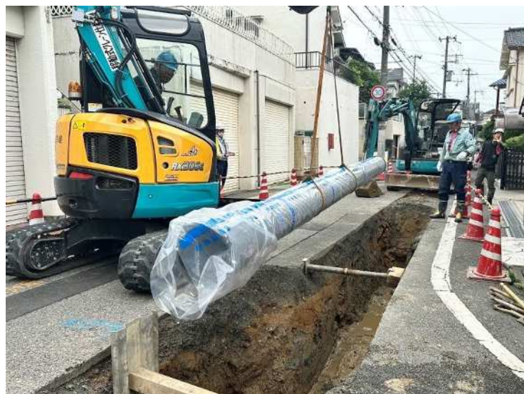
配水管更新工事 （開削）
