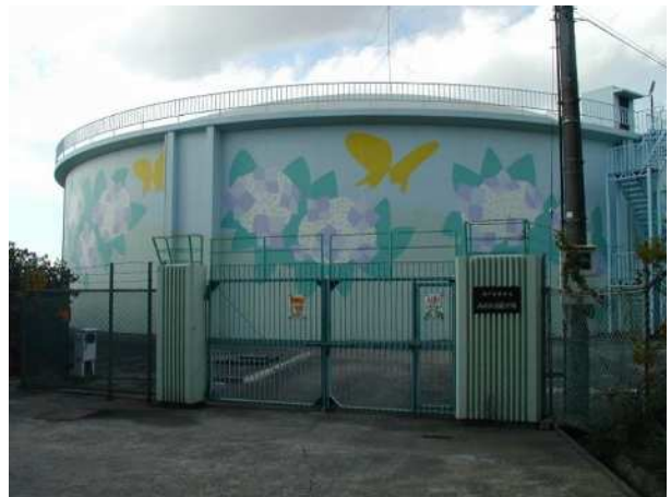
西神低層配水池
