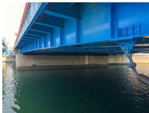
橋梁補修 (兵庫区 高松橋)
