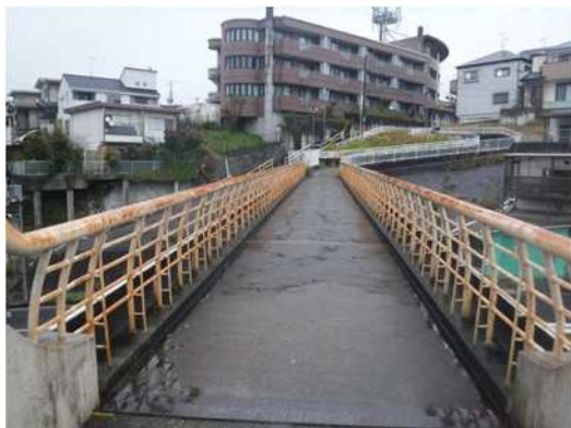
手すりの整備前
