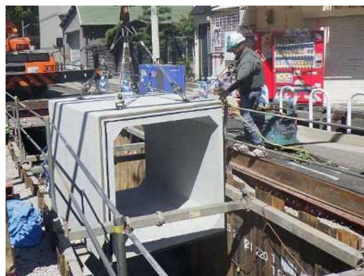
内水圧対策としてボックスカルバートへの改築 （長田区 海運町）
