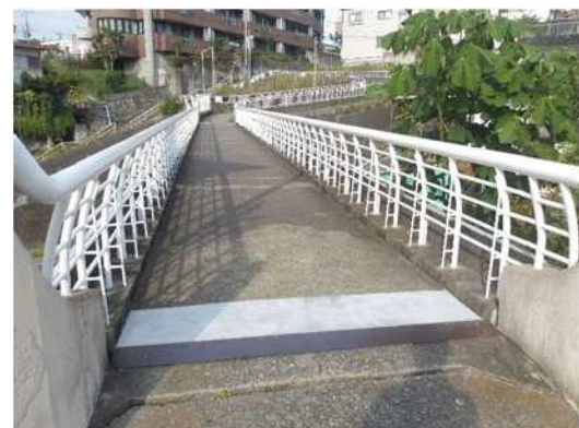
手すりの整備後
