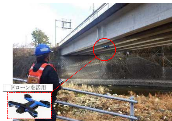
橋梁点検 (北区 新坂本橋)
