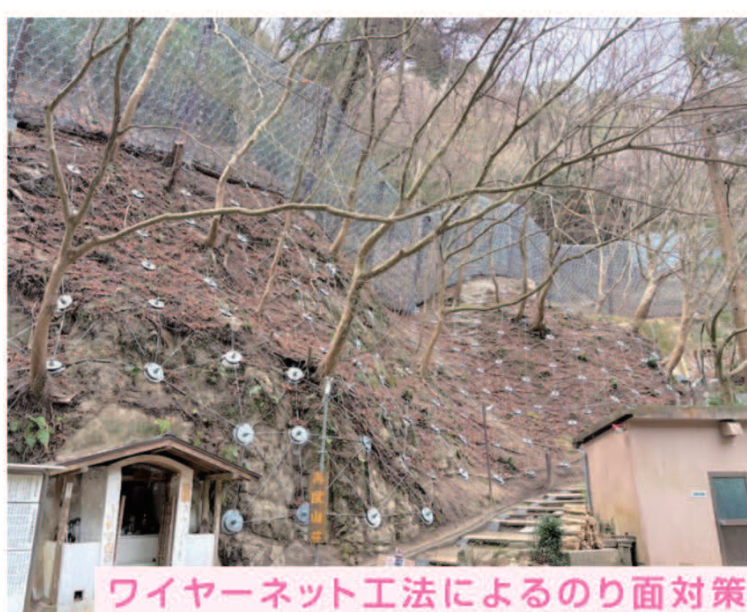
ワイヤーネット工法によるのり面対策
