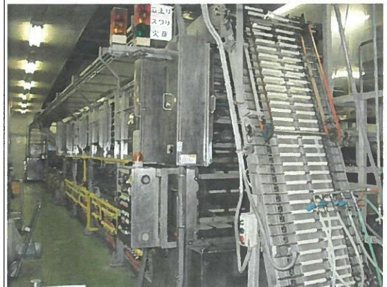
工場1階 竹輪生産設備
