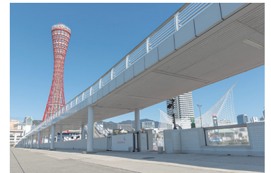
津波対策・防潮堤
