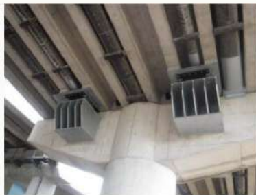
橋梁耐震補強(櫛谷第一大橋)
