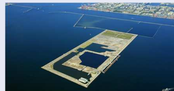
〔神戸沖埋立処分場〕
