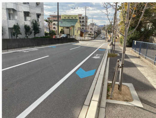
車道混在(鳴尾御影線)
