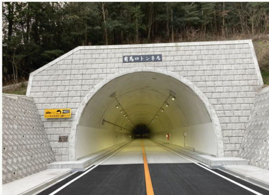
有馬トンネル整備後
