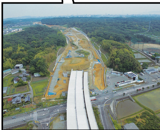
神戸西バイパス整備状況
