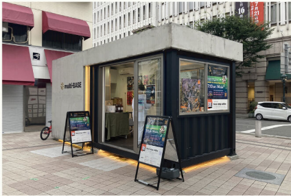
「ほこみち」を活用したコンテナハウス(大丸神戸店前)
