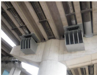
橋梁耐震補強(樫谷第一大橋)
