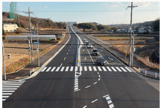
神戸三木線(木幅)整備後
