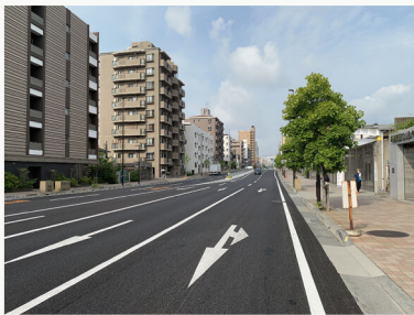
緊急輸送道路の無電柱化(山手幹線(本山))
