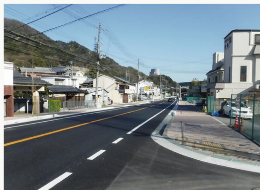
垂水妙法寺線 整備後
