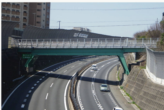
橋梁補修(高丸橋)
