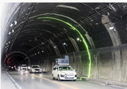
画像計測技術を活用したトンネル点検
