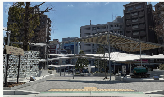
灘駅（南側）整備後
