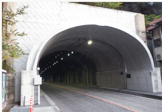
トンネル補修(鉄拐山トンネル)
