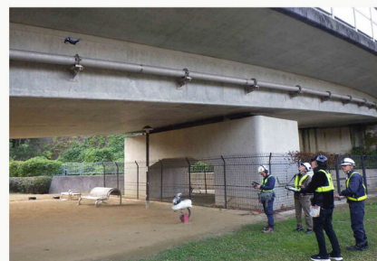
ドローンを活用した橋梁点検
