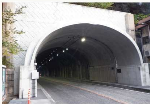
トンネル補修(鉄拐山トンネル)
