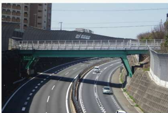
橋梁補修(高丸橋)
