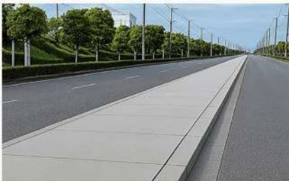
中央分離帯の舗装化による雑草対策
