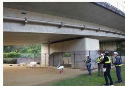
ドローンを活用した橋梁点検
