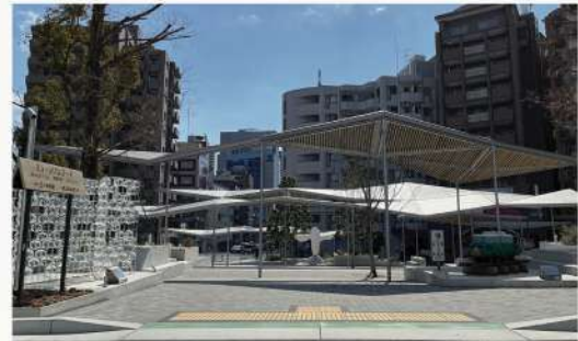
灘駅（南側）整備後
