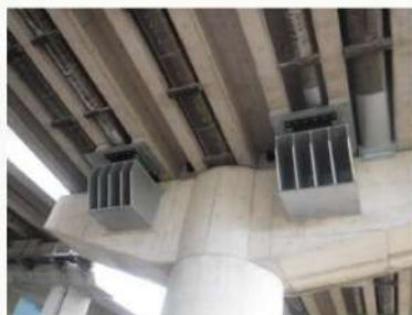
橋梁耐震補強(樺谷第一大橋)
