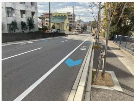
車道混在(鳴尾御影線)
