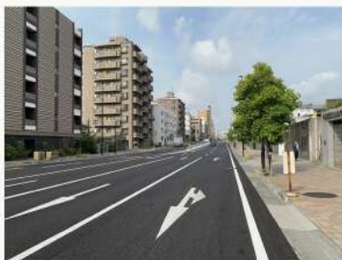
緊急輸送道路の無電柱化(山手幹線(本山))
