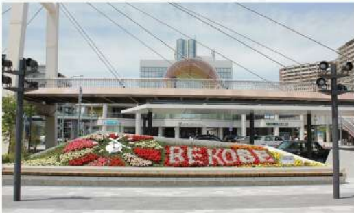
西神中央駅（西側）整備後
