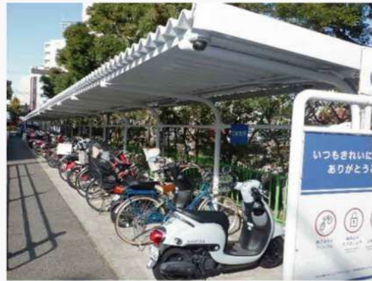
屋根を補修した駐輪場（新開地駅）
