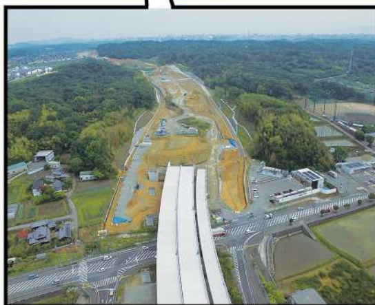
神戸西バイパス整備状況
