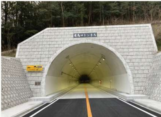
有馬口トンネル整備後
