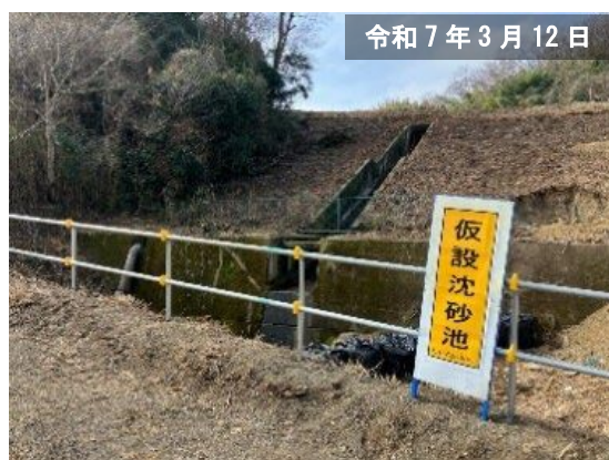
仮設沈砂池の設置
