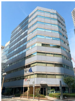
5 神戸伊藤町ビルディング
