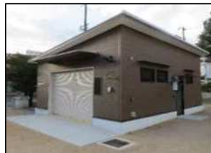
【消防団器具庫・詰所】
