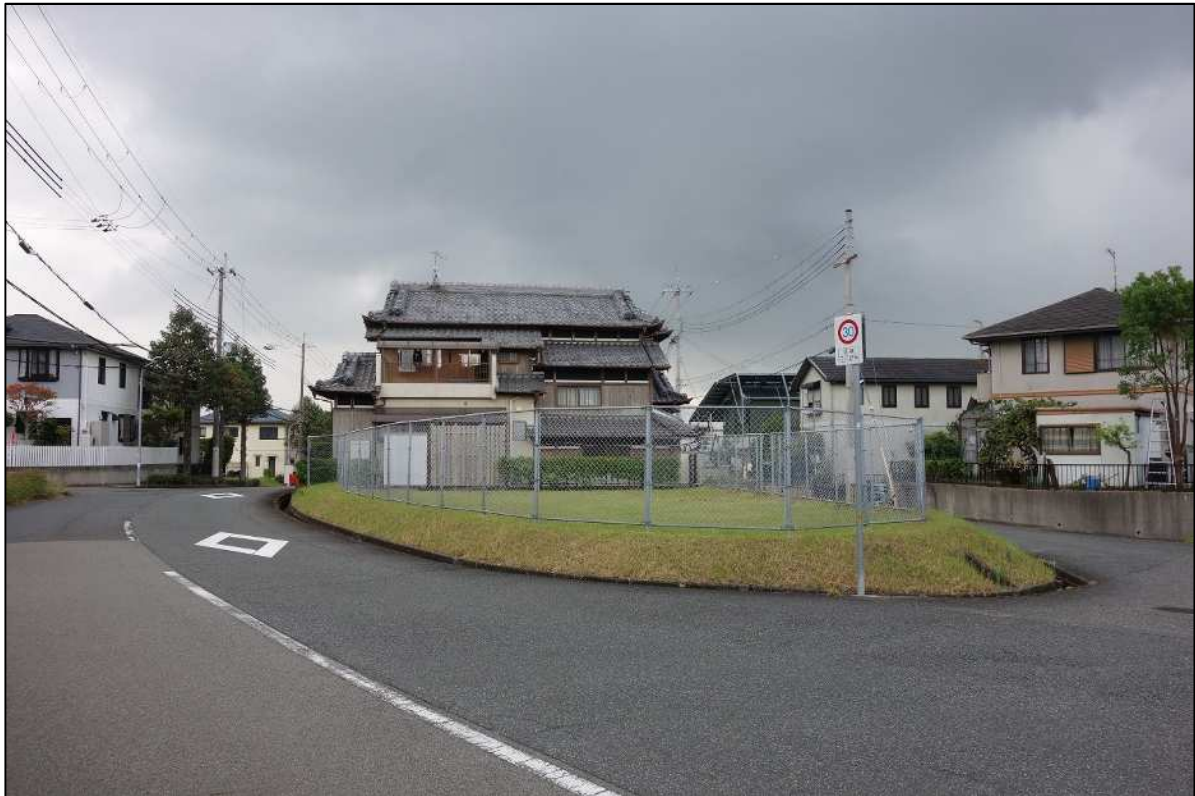
北東から南西を撮影
