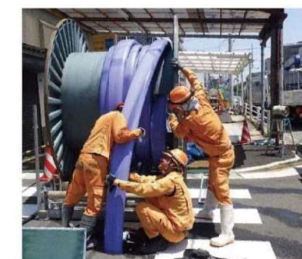
管更生工法による改築更新工事
