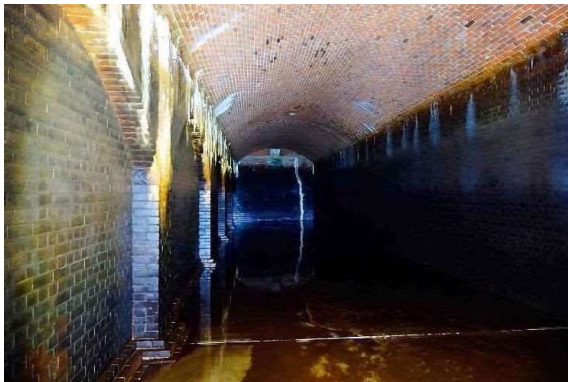
奥平野低層配水池
