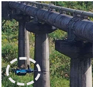
ドローンによる点検
