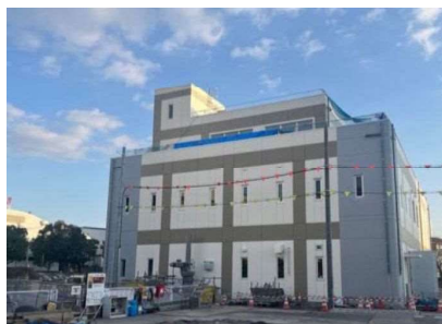
新東川崎ポンプ場整備事業(中央区)
