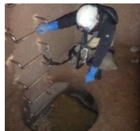
マンホール内の目視点検
