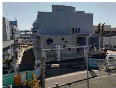
魚崎ポンプ場改築更新事業(第1期)(東灘区)
