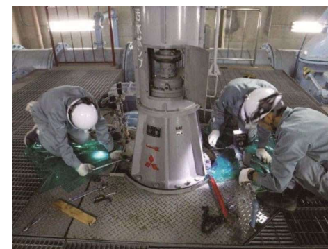
設備の補修・修繕
