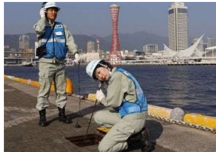
漏水調査の様子
