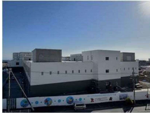
西部処理場北系整備（長田区）
