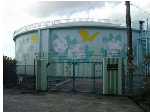
西神低層配水池
