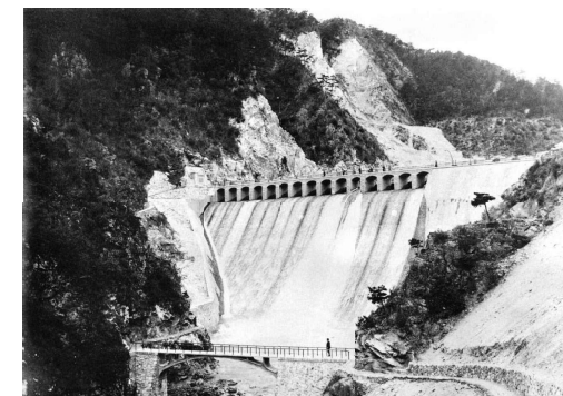
完成直後の千苅貯水池大堰堤
