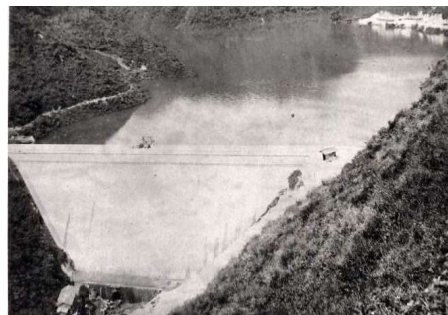
完成直後の布引貯水池五本松堰堤
