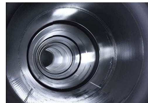
大容量送水管の内部(直径2.4m)
