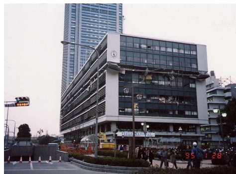
被災した本庁舎
