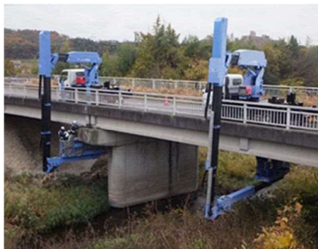
橋梁点検車による点検
