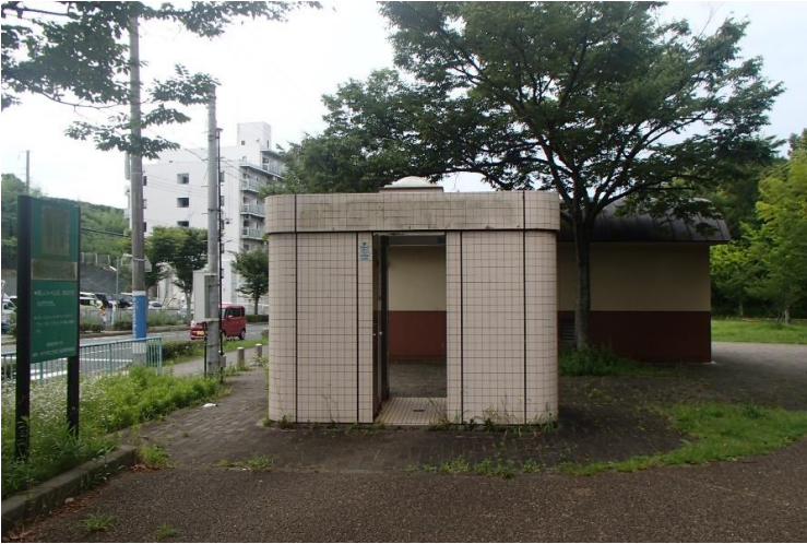
▶トイレ再整備前（外観） 池上中央公園
