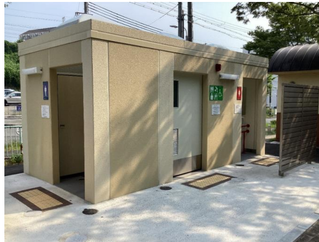
▶トイレ再整備後（外観）
