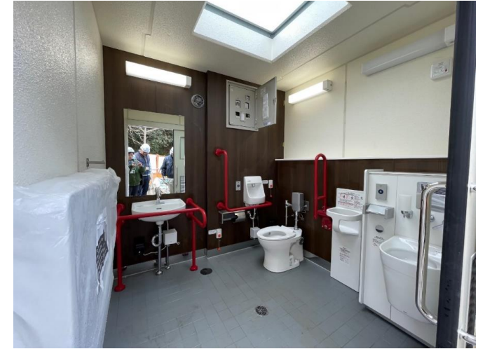
▶トイレ再整備後（内観）
