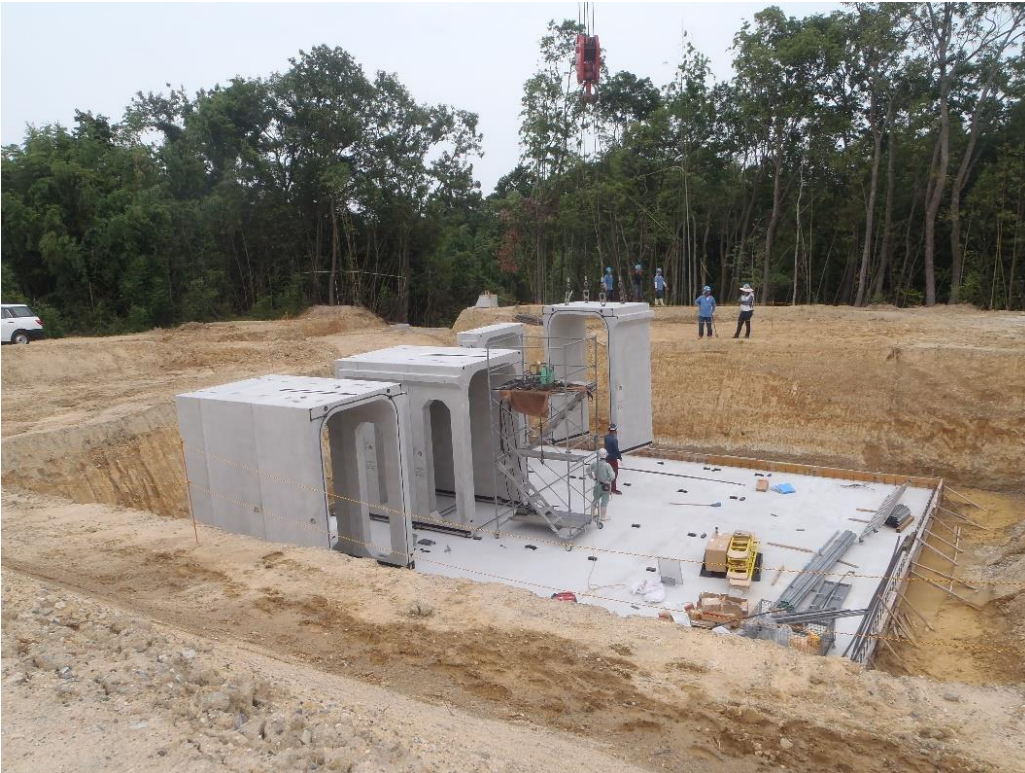
▶雨水貯留槽設置 | 押部谷町公園
