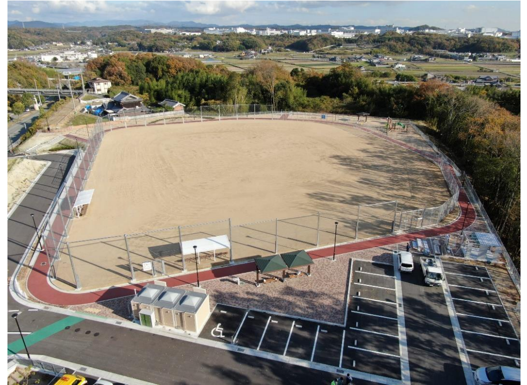
▶公園整備後 | 押部谷町公園
