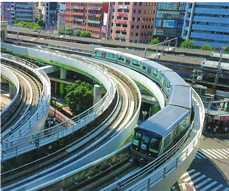
わが会派の指摘により「耐震補強未着手」の箇所が多数判明した神戸新交通ポートライナー
