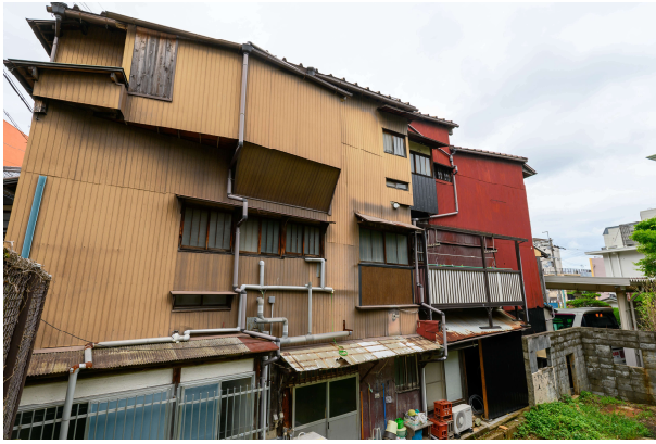
金の湯付近から見る東側外壁。焼杉板張などでの修景が望まれる。
