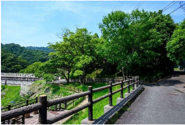
①南岸護岸道路から管理事務所棟周囲の樹木を見る。樹木が大きく茂っていて管理事務所棟を隠している。
