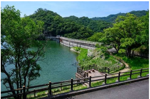
⑤南岸「亀の甲広場」より堰堤を見る。堰堤を見下ろすように見ることが出来る。
