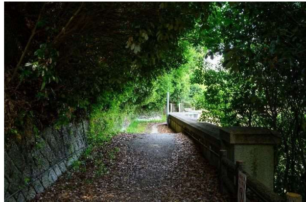
⑥北岸「水と森の回遊路」から堰堤西端部を見る。樹木が生い茂り薄暗く堰堤も隠れている。樹間を抜けると堰堤や取水塔覆屋が見え期待感が高まる。
