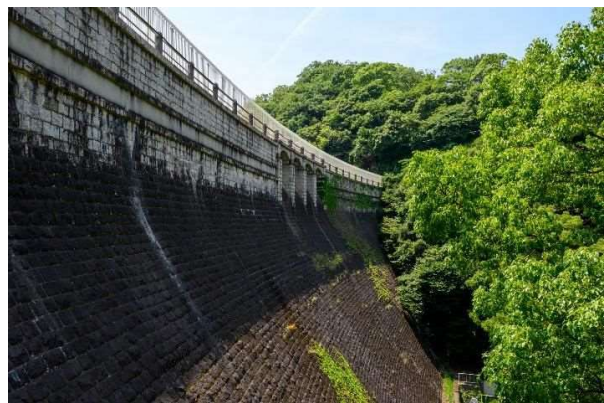
堰堤背面（下流側）を見る 緩やかに曲線を描く間知石積みの堤壁は見る人を圧倒する
