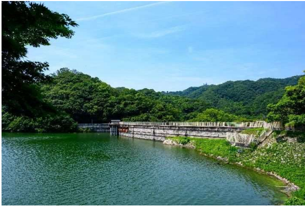
①南岸「水と森の回遊路」の見晴らし台から堰堤を見る。湖面に近く堰堤を見ることが出来る。
