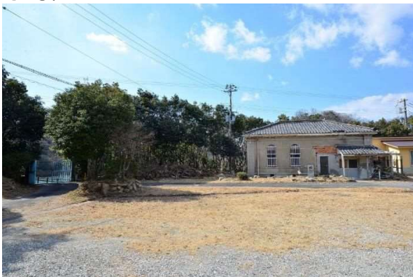
⑦管理事務所棟前広場から出入口門を見る。管理事務所からも貯水池が見えづらい。
