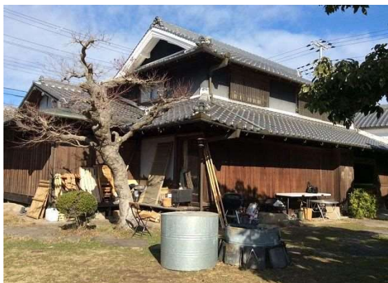
木造・つし2階建の主屋。大正期の建築後、昭和47～49年頃増改築し、畑を作庭する。建物の施工者は不詳。
