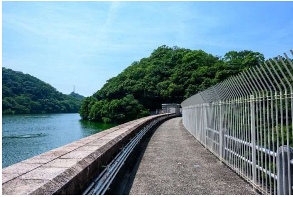
堰堤頂部の通路は洗い出し舗装になっている 上流側は胸壁が立ち上がる一方で下流側は手摺となっている
