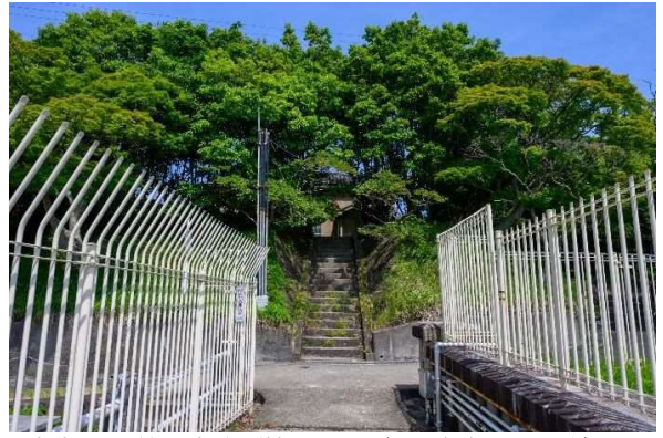
④堰堤から管理事務所棟を見上げる。堰堤の延長線上に管理事務所棟が建ち、機能的な動線が反映されている。
