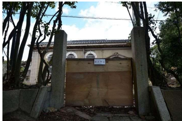
⑧堰堤につながる管理事務所棟の門は通行不可。行き来が可能になれば管理事務所棟が認知される。
