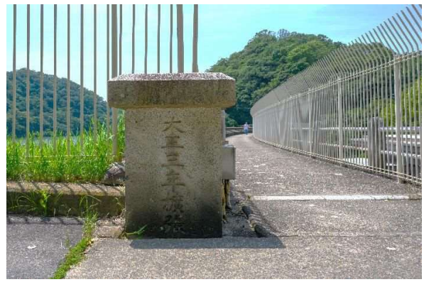
堰堤南端部の花崗岩製の胸壁端部 「大正三年擴張」の文字が刻まれている
