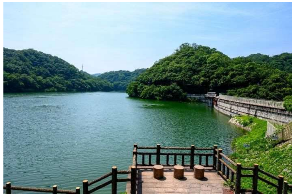
④南岸護岸道路からは堰堤と同じアイレベルで堰堤や貯水池を奥まで見通すことが出来る
