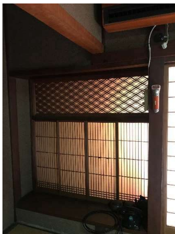
2 階南客室の付書院。欄間部分の組子が、繊細な意匠をしている。
