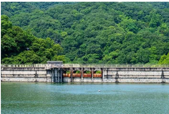
取水塔覆屋と余水吐を貯水池側から見る 4連アーチの余水吐扉門は鉄製
