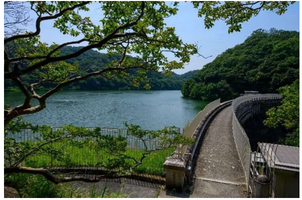
⑩堰堤東端の管理事務所棟への階段から堰堤を見る。堰堤の弧を描く様子がよく分かる。
