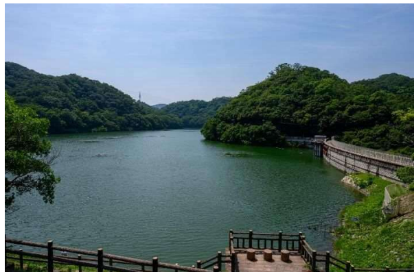
⑥南岸「亀の甲広場」より堰堤および貯水池を見通す。堰堤や貯水池を見下ろすことが出来る。
