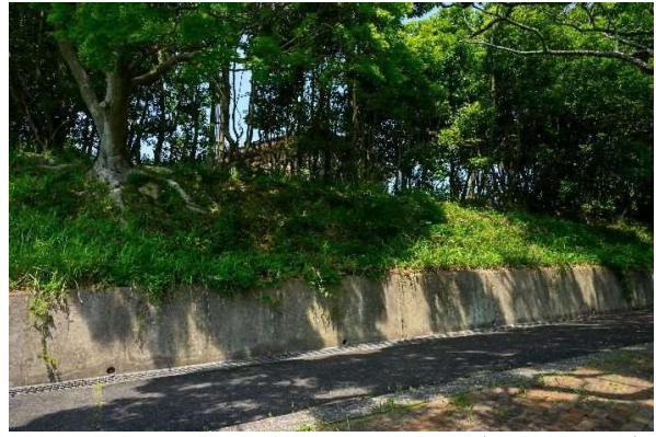
②護岸道路から管理事務所敷地を見上げる。防風林が視覚を遮っている。
