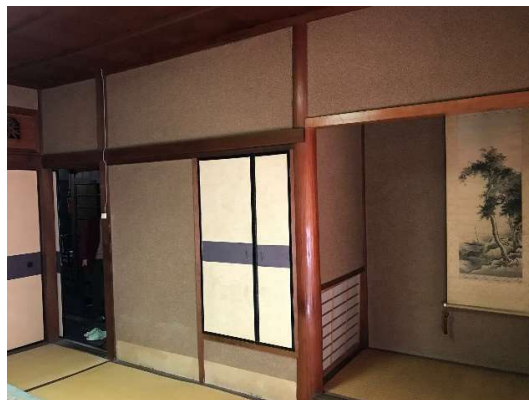
2 階南客室の床の間廻り。
