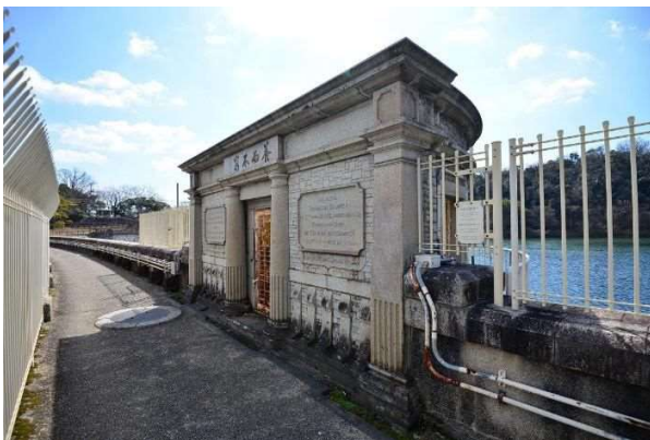
取水塔覆屋を北から見る 覆屋は19世紀中頃に流行した新古典主義様式を取り入れた意匠
