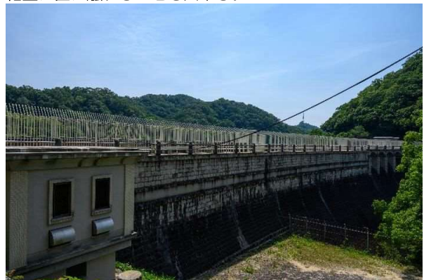
⑯石井川沿いから貯水池への細道を上りきって堰堤を見る。弧を描く堰堤の長さがよく分かる。
