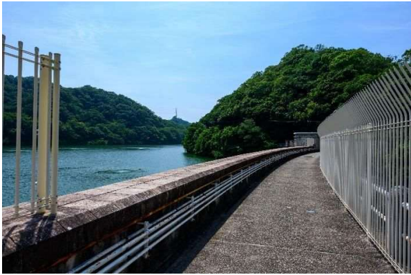
⑨堰堤上から取水塔覆屋を見る。落下防止策が途切れ、貯水池・水面が最も近く感じる場所。
