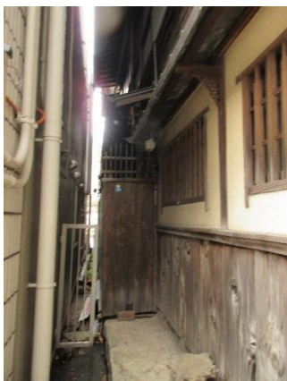
西壁部分。現在は、隣接のビルで視認性は悪いが、元の特徴である高欄や玄関の開口窓の納まりなどが見て取れる。
