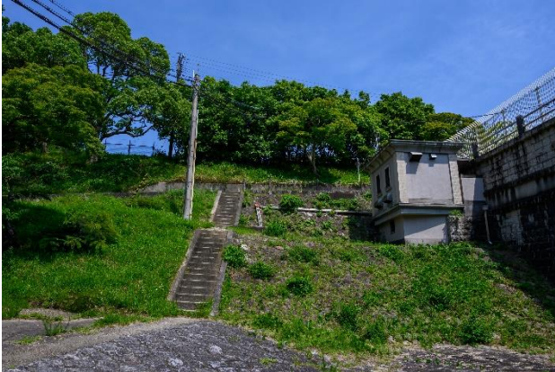
⑲堰堤東側の空地から管理事務所棟を見上げる。かつてはこの空地に混糞室が建っていた。
