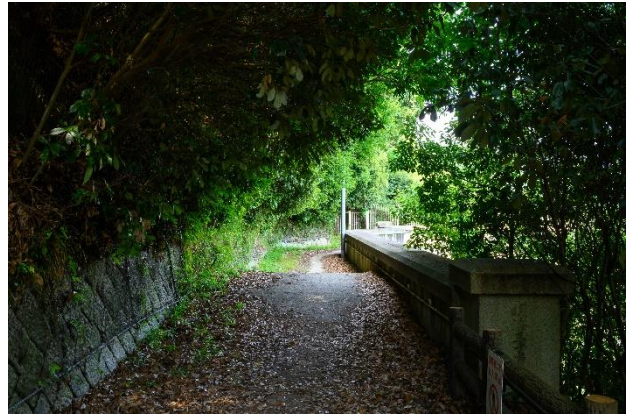
㉒北岸「水と森の回遊路」から堰堤西端部を見る。樹木が生い茂り薄暗く堰堤も隠れている。樹間を抜けると堰堤や取水塔覆屋が見え期待感が高まる。
