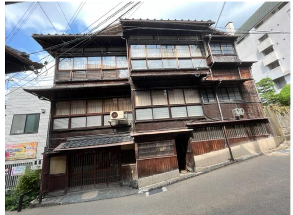
かつては、高欄が外部から望めていた様だが、現在はガラス戸で覆われている。間口の大きな構えの旅館である。
