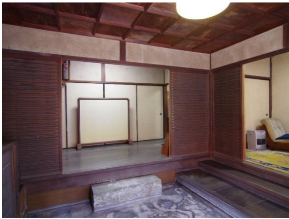
玄関室。天然墨を入れた三和土の土間と格天井、色漆喰壁など、来客に向けた豪華な設え。
