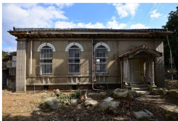
外観は近代洋館建築の意匠が取り入れられている。 西面は3連のアーチ窓の上部に縁取りがあり、意匠性が強調されている
