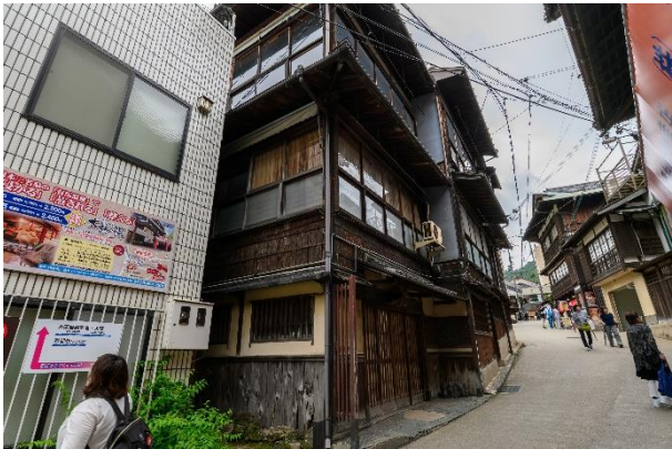
湯本坂の起点からみる。手前の建物はかつての高級風呂（明治43～大正15）であった場所。
