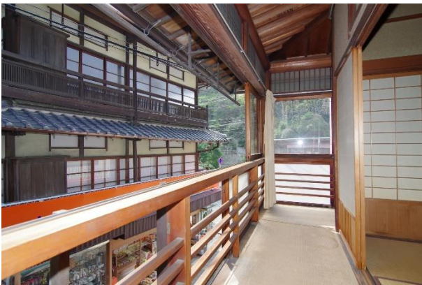
同 2 階南客室の紙障子から縁側と高欄。
