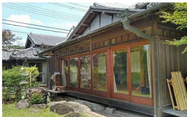
主屋西面、増改築して屋根銅板葺き一文字瓦葺き。庭の蹲、南側入隅の待合。茶室建築の構えを意識している。
