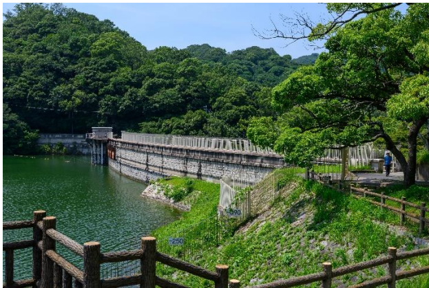
③南岸護岸道路から堰堤を見る。堰堤と同じアイレベルで堰堤を見ることが出来る。
