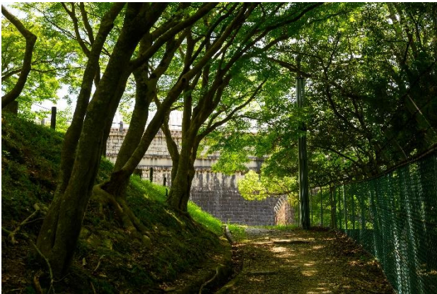
⑬石井川沿いから貯水池への山の細道から堰堤を見る。そそり立つ堰堤の絶壁が徐々に見えてくる。
