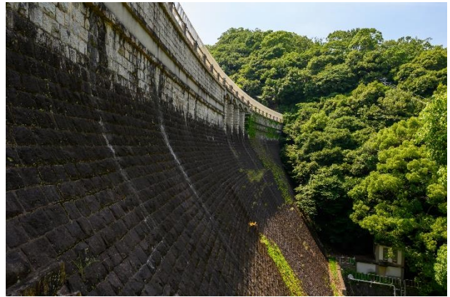
⑭堰堤東側の空地から堰堤を見渡す。下流側は弧を描く石の絶壁がよく見え、堰堤の規模を体感できる。堰堤の絶壁に直に触れることも出来る。
