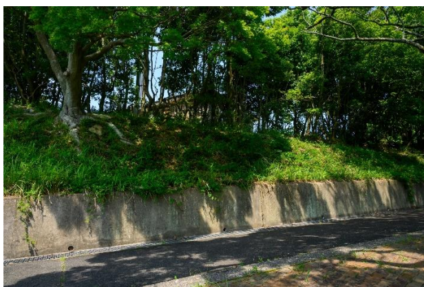
管理事務所を護岸道路から見上げる。防風林が貯水池からの強風を遮断する役目を果たしつつも、来訪者から視覚的に隠す。
