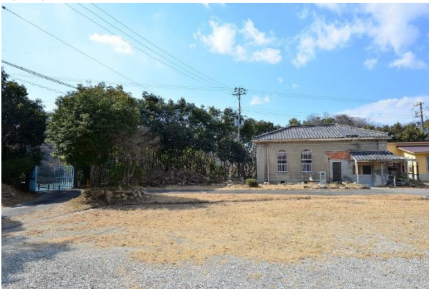
㉓管理事務所棟前広場から出入口門を見る。管理事務所からも貯水池が見えづらい。
