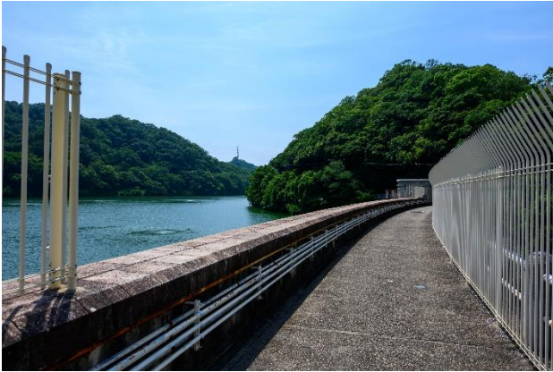
⑨堰堤上から取水塔覆屋を見る。落下防止策が途切れ、貯水池・水面が最も近くに感じる場所。
