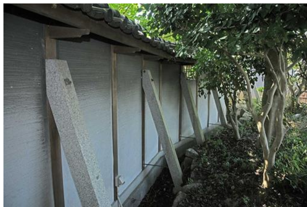
塀(中)の敷地内部の様子。友清川の護岸には、3段に分かれた塀が設置されている。
