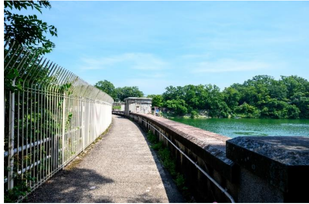
⑫堰堤西端から見る。取水塔覆屋越しに南岸護岸道路のモミジなどの並木を見ることが出来る。
