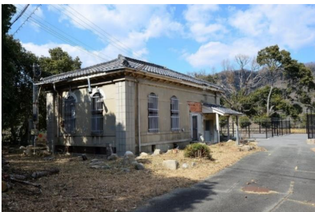
管理事務所棟を南東から見る 管理事務所棟は日常の維持管理を行う拠点となっていた
