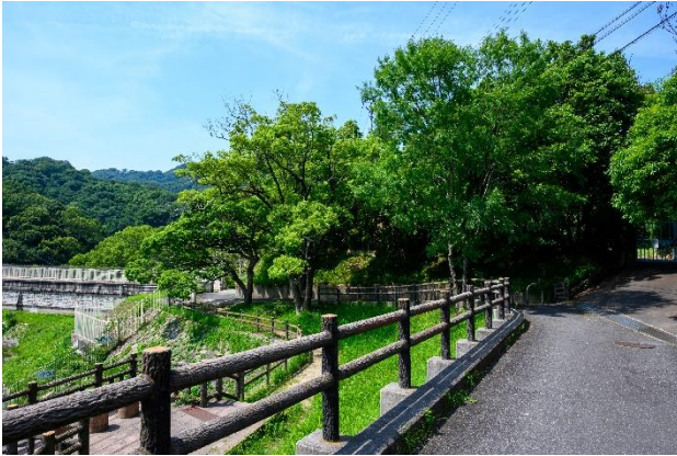
⑰南岸護岸道路から管理事務所棟周囲の樹木を見る。樹木が大きく茂っていて管理事務所棟を隠している。
