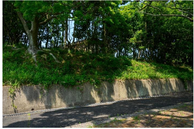
⑱護岸道路から管理事務所棟敷地を見上げる。防風林が視覚を遮っている。
