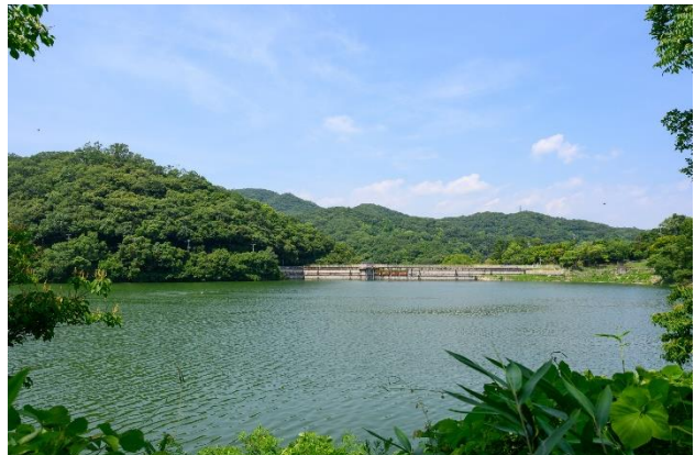
⑧南岸「水と森の回遊路」から堰堤を見る。湖面越しに堰堤を正面に見ることが出来る。
