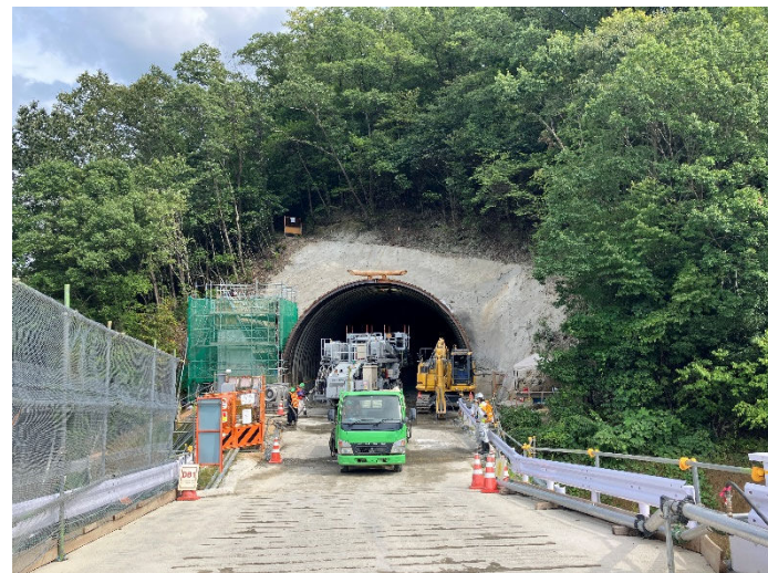
②抱き擁壁工 施工状況
