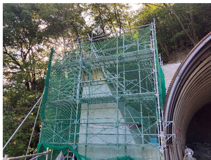
②抱き擁壁工 施工状況
