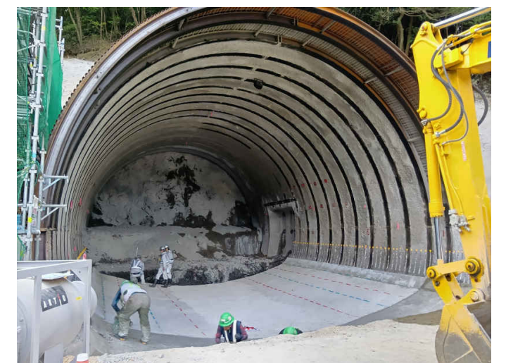
⑧インパットコンクリート施工状況
