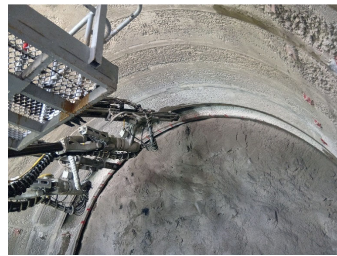
⑥充填式フォアボーリング鉄筋挿入状況
