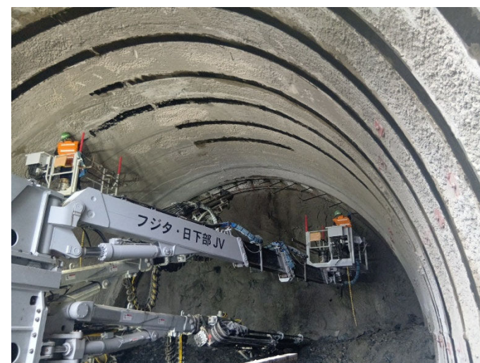
⑥充填式フォアボーリング鉄筋挿入状況
