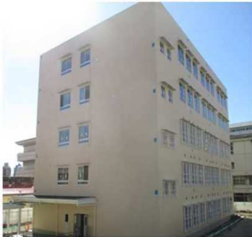
写真 湊小学校の暫定校舎（右写真内赤枠部）
