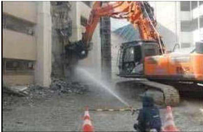
躯体解体時の散水
