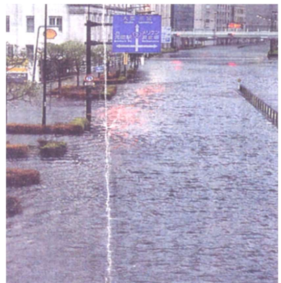
図 6-2-3 2 号線冠水の様子
