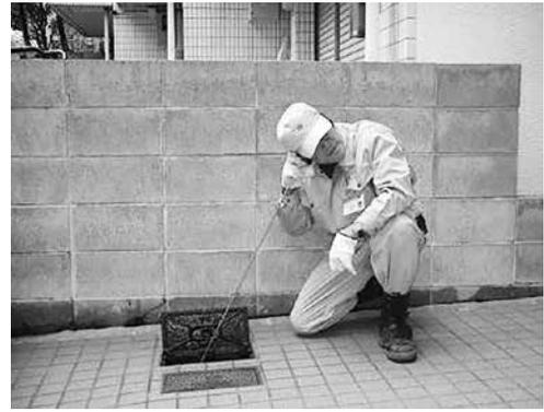
写真2：音聴棒による弁栓音聴調査
