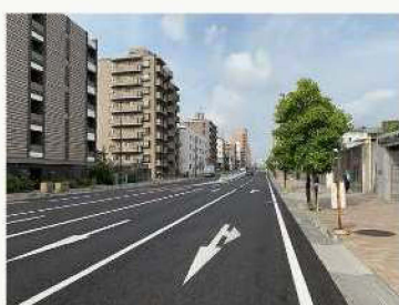
緊急輸送道路の無電柱化（山手幹線）
