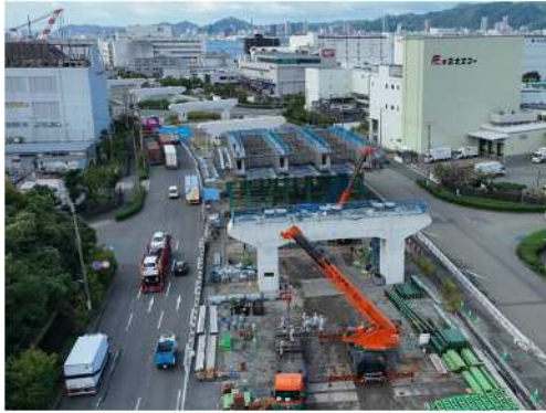
大阪湾岸道路西伸部 整備状況
