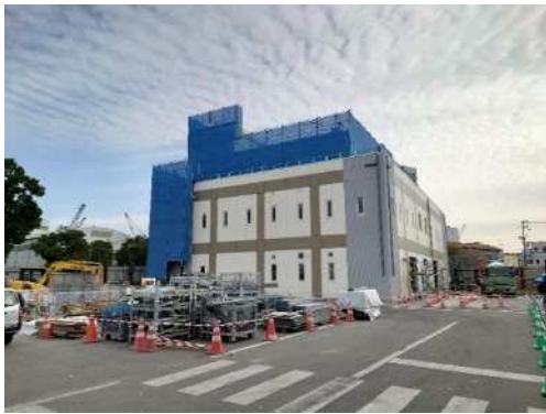
新東川崎ポンプ場整備事業 (中央区)
