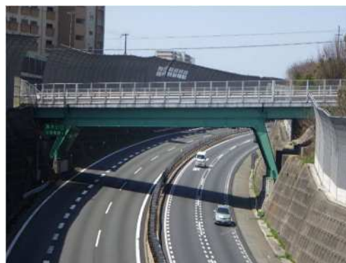
橋梁補修 （垂水区 高丸橋）
