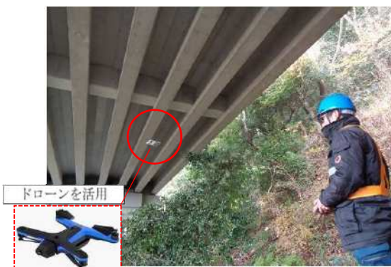
橋梁点検 （北区 岩谷橋）
