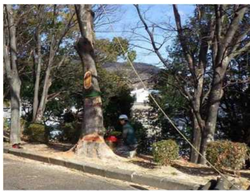
公園の危険木伐採
