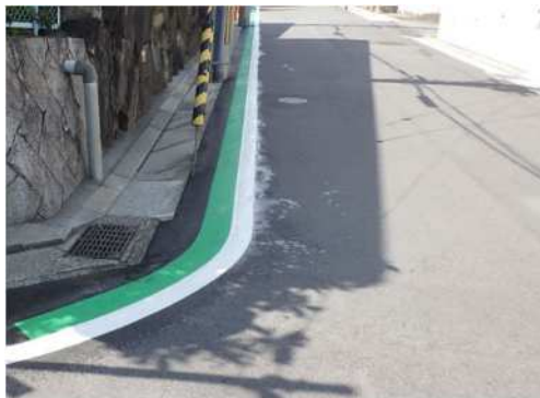
路側帯のカラー化 （東灘区本山第一小学校付近）
