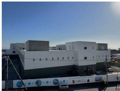
西部処理場北系整備（長田区）
