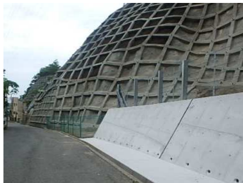
土砂災害特別警戒区域の斜面对策後 (灘区 箕岡通)
