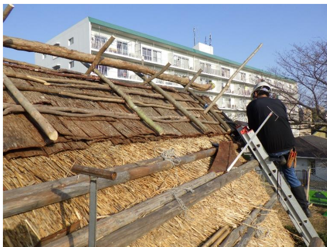
茅葺屋根葺き替え作業中
