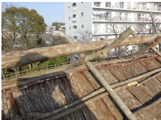
完成した屋根
